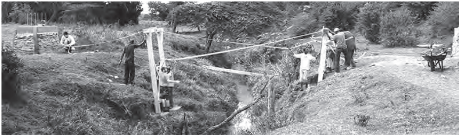
Aufstellen des Lehrgerüsts
