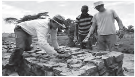
Widerlager der Brücke
