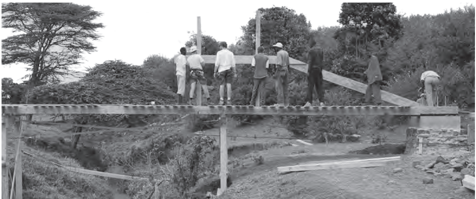
Montage des Obergurts
