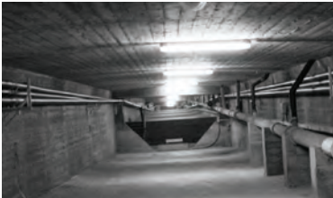
Schwarzwaldbrücke - Brückenkasten von innen
