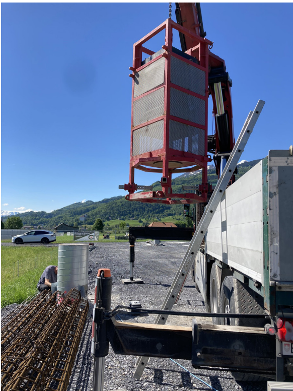
Prüfung eines Pfales
