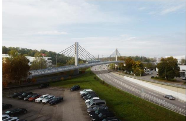
Das Projekt der Glattalbahn nimmt einerseits Rücksicht auf den Bestand der bestehenden Verkehrsflächen und andererseits auf die geplante Neuordnung der Verkehrserschliessung im Bereich Facht Ost des Flughafens. Zudem ist auf einen späteren Ausbau der Autobahn A51 auf 6 Spuren Rücksicht zu nehmen. Aus dem umfangreichen Variantenstudium resultiert ein rund 440 m langer Viadukt, welcher über die Verkehrsflächen im Bereich Knoten Fracht sowie über die Autobahn geführt wird.
