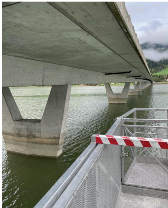
Hauptinspektion des Steinbachviadukts mittels Brückenuntersichtgerät
