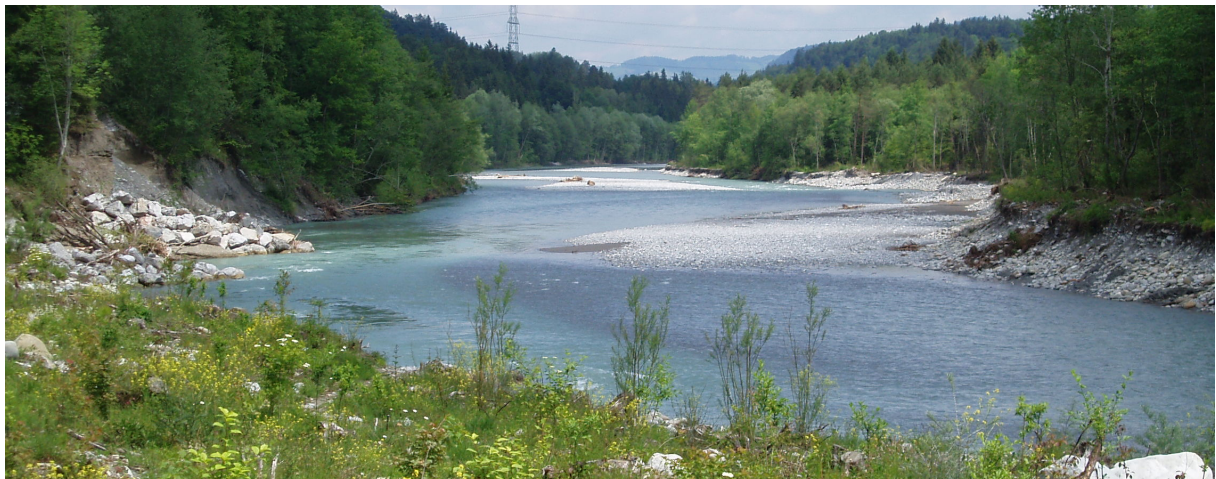
Revitalisierung Aufweitung Augand, Kander, Kt. Bern (Flussbau AG)
