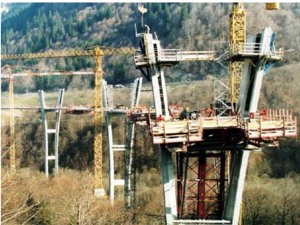
Auf Höhe der zweiten Pylone (von Büel aus gesehen), wird die höchste Stelle der Brücke erreicht, denn hier befindet sich die Fahrbahn rund 62 Meter über der Landquart, die unweit des Brückenpfeilers am Talboden entlang fließt. Jeder der vier Pfeiler hat ein Fundament, das rund 16 Meter tief gegründet ist.
