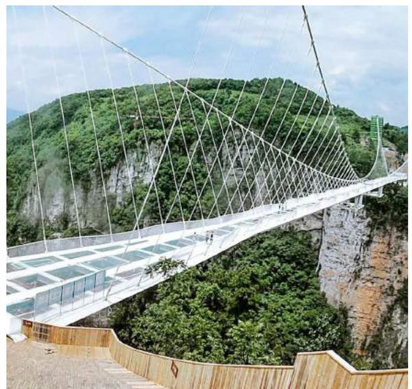
Das Grundgerüst der Brücke besteht aus mit Zement verstärkten Stahlträgern. Darin eingepasst wurden drei übereinandergelegte Glaspaneele, was zu einer Bodendicke von insgesamt gerade einmal 60 cm an den dicksten Stellen führt. Über die Gesamtlänge von 430 Metern
